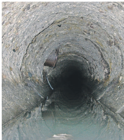
Potrubí před opravou a po bezvýkopové opravě
